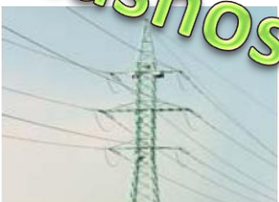
Stožárová konstrukce “Souděk”, typ kotevní “Barrel” anchor tower
