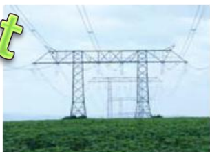
Dvojité vedení 2x220 kV. Stožárová konstrukce “Portál dvojnásobný” Double 220kV line. “Double portal” tower
