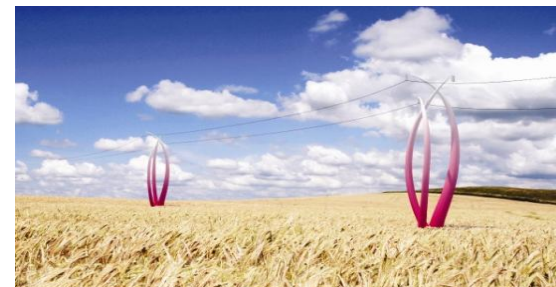
Dvojité vedení 2x220 kV. Stožárová konstrukce “Portál dvojnásobný” Double 220kV line. “Double portal” tower
