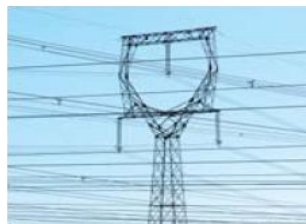
Jednoduché vedení 1x400 kV. Stožárová konstrukce „Delta“, typ nosný Single 400kV line. “Delta” suspension tower
